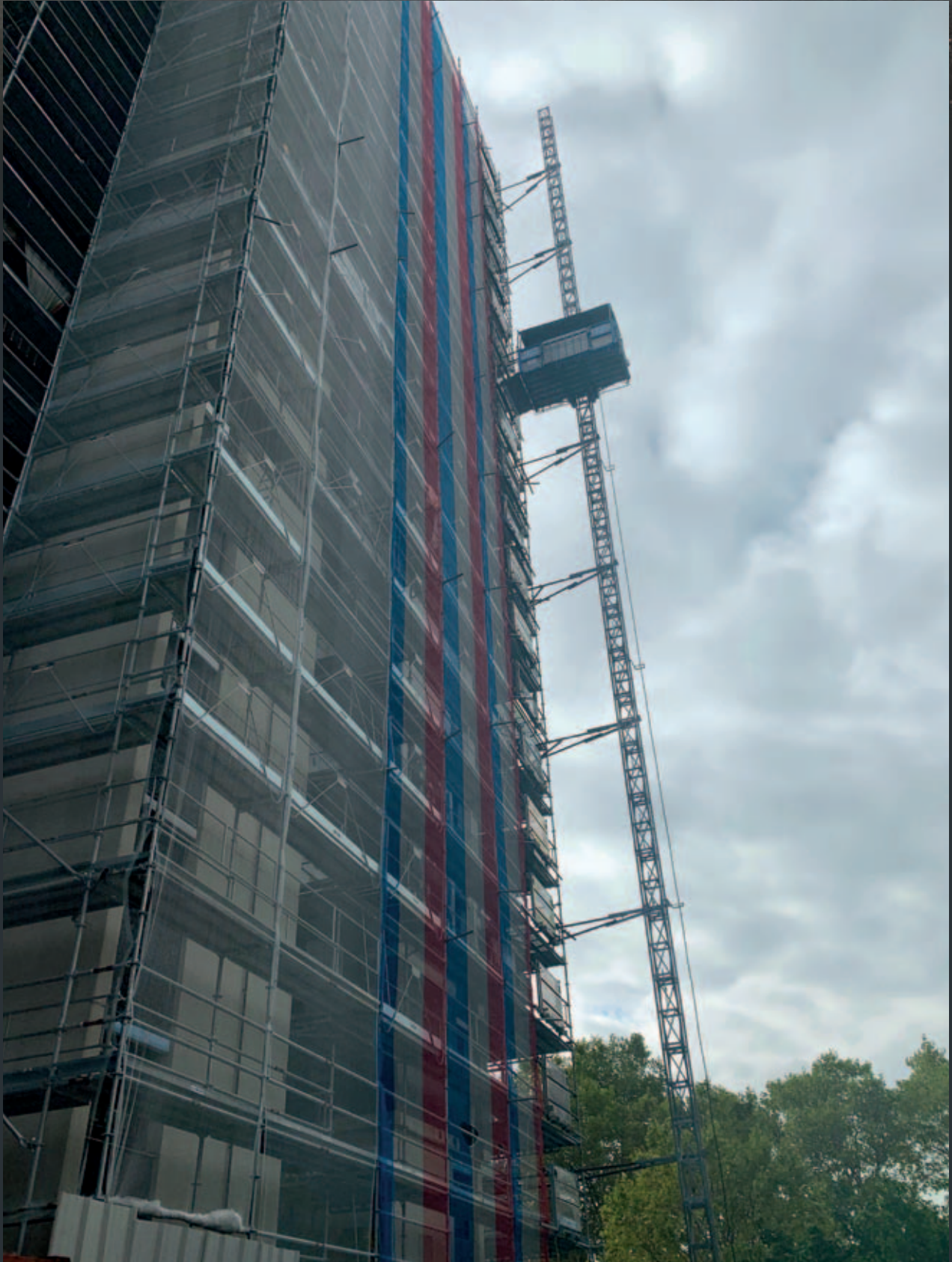
Résidence Marie Reynoard, Grenoble, France / Marie Reynoard Residence, Grenoble, France
