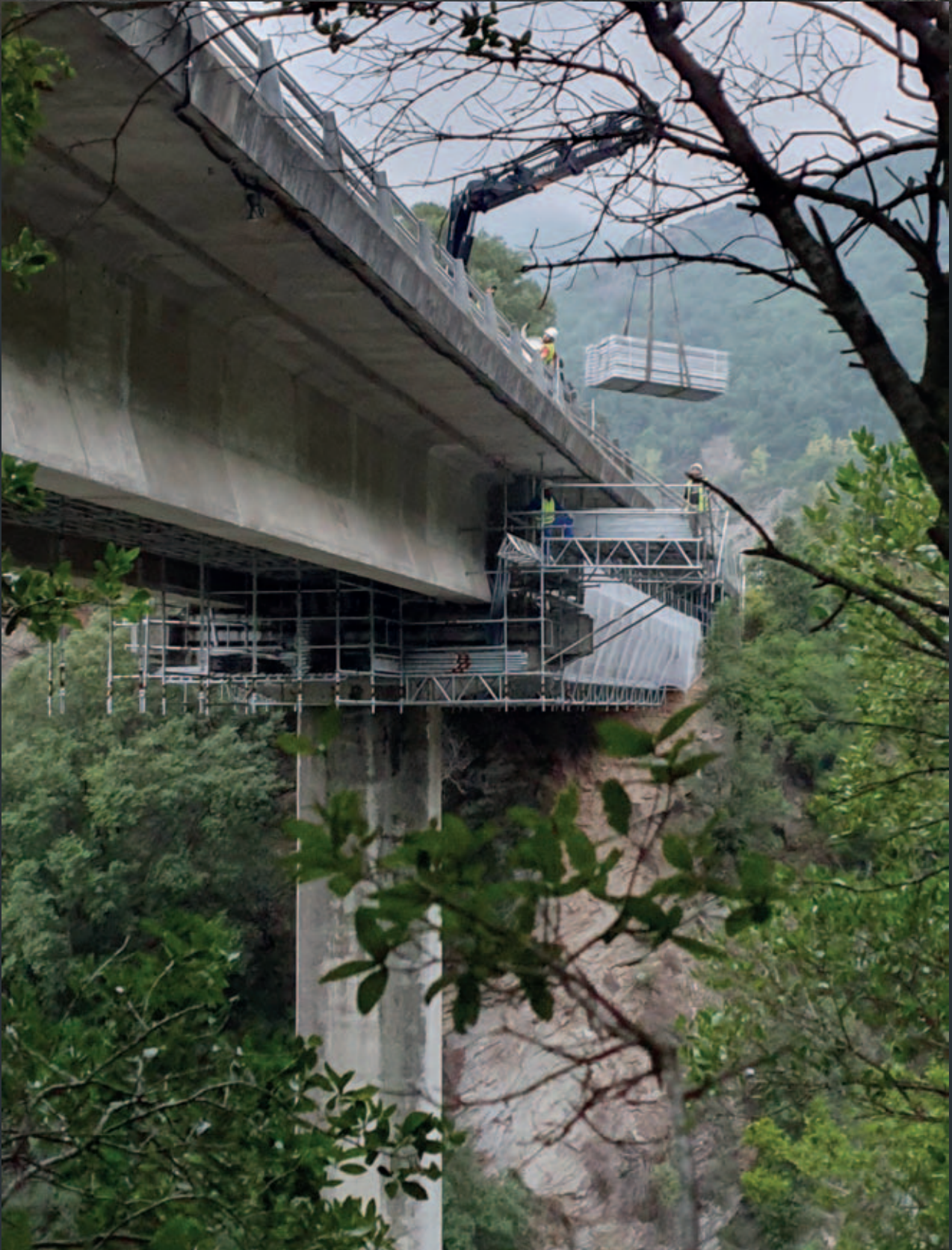
Pont de Faju, Nonza, Corse du Sud, France / Faju Bridge, Nonza, South Corse, France
