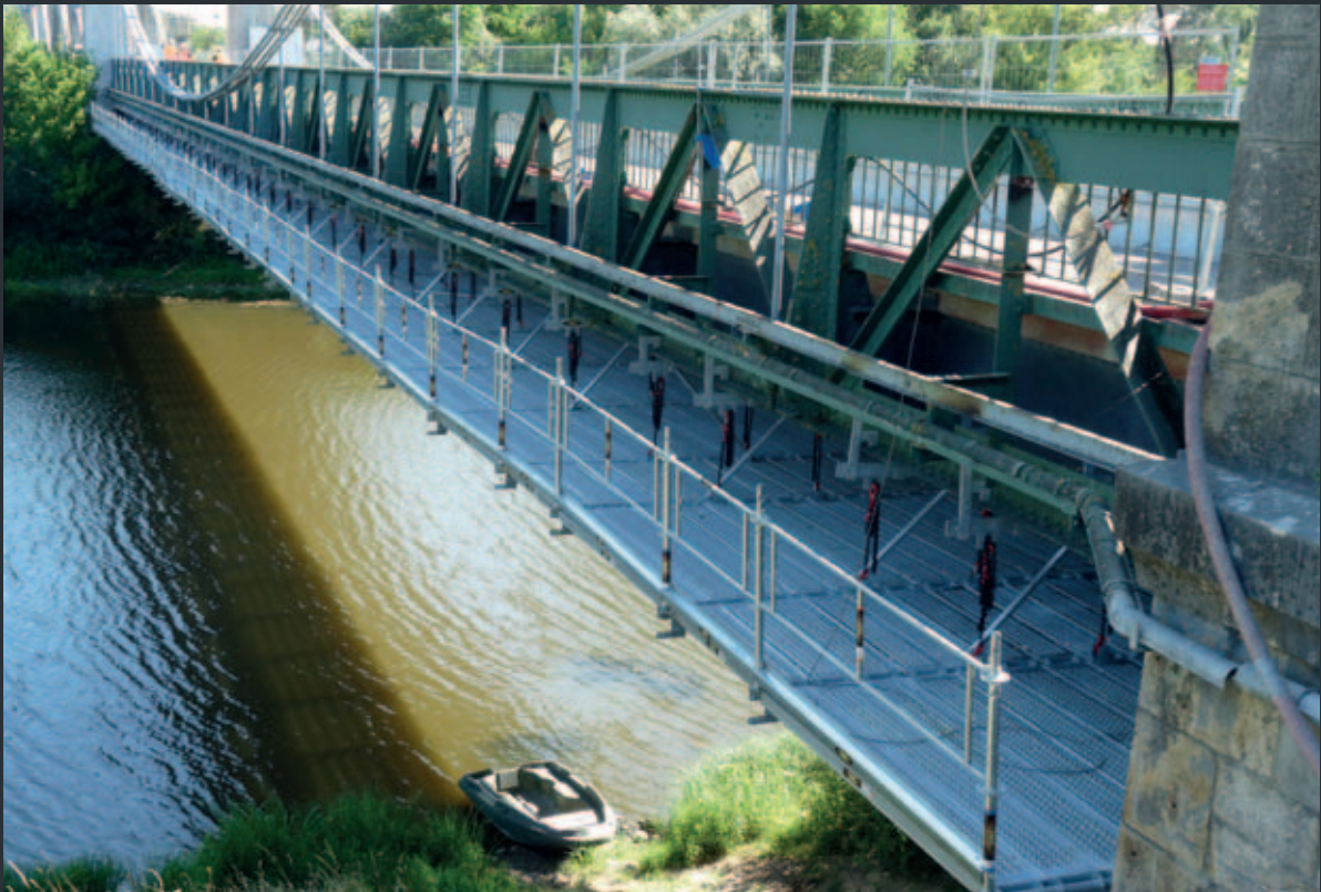
Echafaudage suspendu et réglable en hauteur, Pont de Châtillon-sur-Loire, France / Suspended and height-adjustable scaffolding, Châtillon-sur-Loire bridge, France
