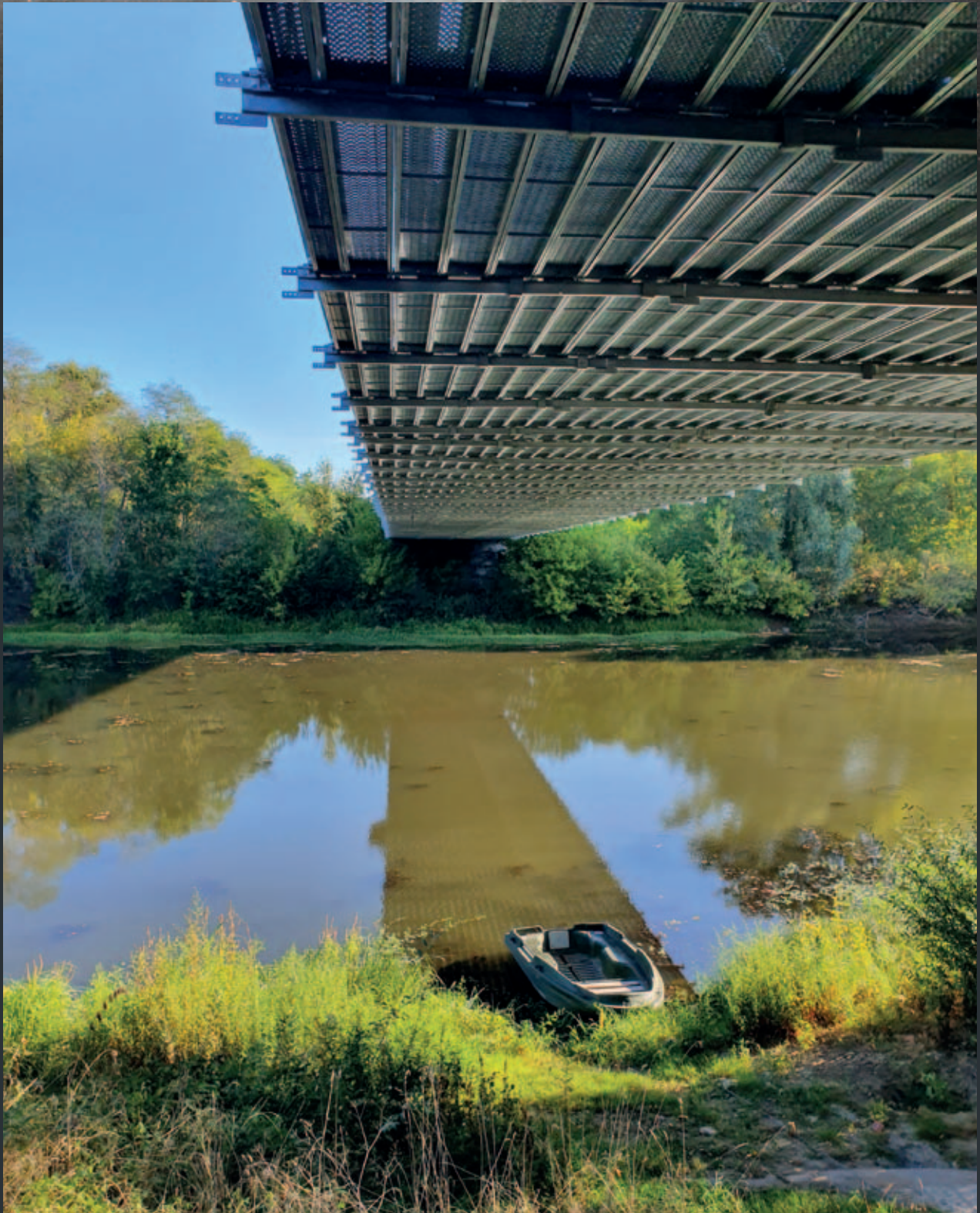
Pont de Châtillon-sur-Loire, France / Châtillon-sur-Loire bridge, France
